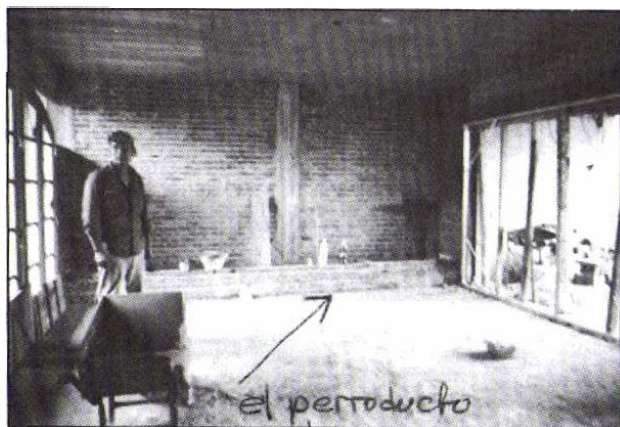
El perroducto durante la construcción.
